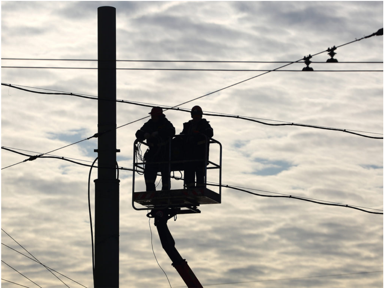
Travailleurs sur des câbles en altitude © Versta DepositPhotos
